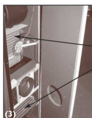
Ailettes des 2 échangeurs
